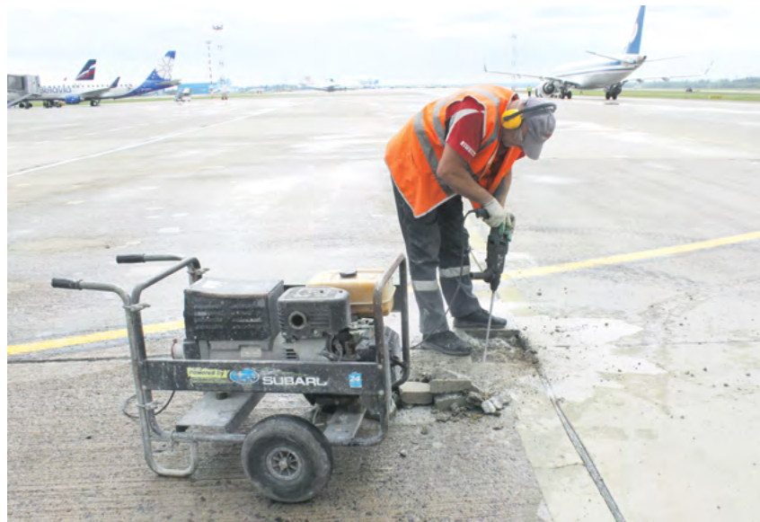
Устранение дефектов на искусственном покрытии
